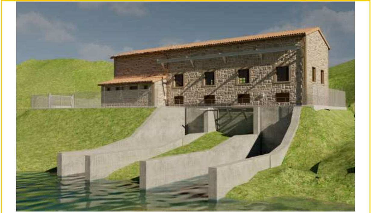
Imagen 18. Central de Irueña Canales de descarga.
