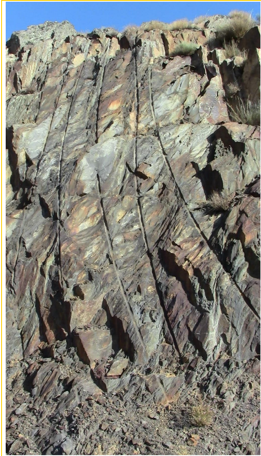
Imagen 58. Aspecto de la roca en un talud subvertical en la carretera de acceso a la galería de la margen izquierda de la presa, con las cañas bien marcadas de la voladura realizada
