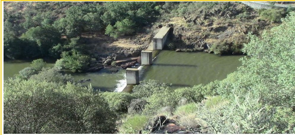
Imagen 24. Vista del giro de entrada de la Tubería Forzada a las turbinas de Casa de Máquinas, en roca Tipo II-III, en la zona de la contraataguía del colchón de amortiguación.
