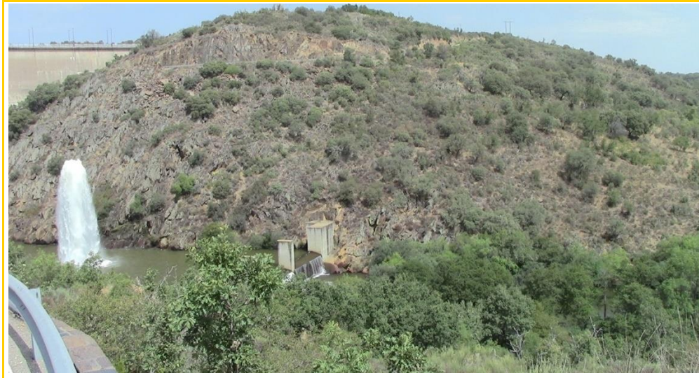
Imagen 33. Vista de la margen izquierda del río Águeda, por donde discurre el trazado de la Línea de Evacuación hasta situarse paralelo a la línea existente, torres 3 a 5.
