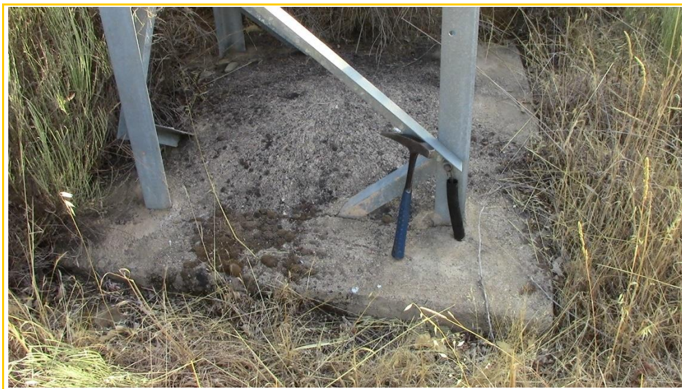
Imagen 35. Cimentación de la torre de la línea existente a la altura de la torre nº 6.
