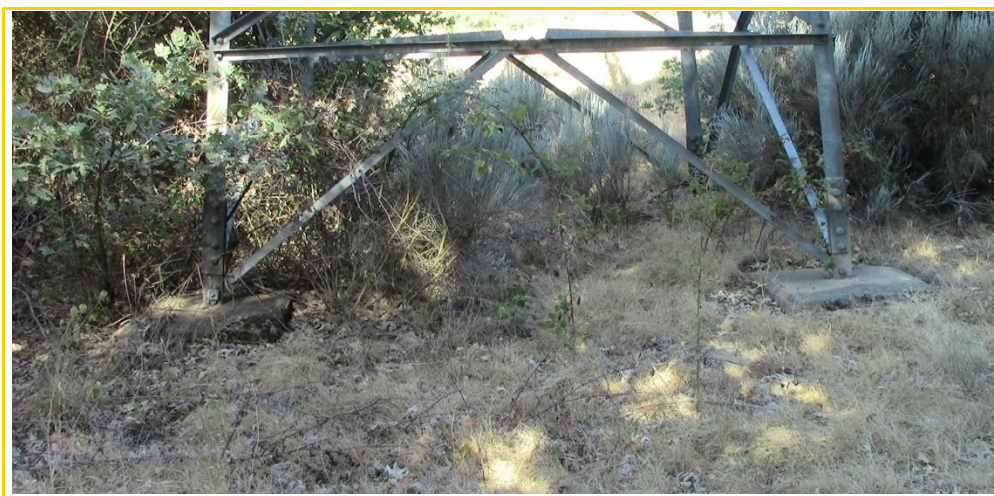
Imagen 44. Cimentación de los apoyos de la torre anterior.
