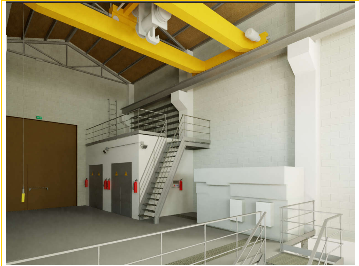
Imagen 9. Nivel de Sala de transformador de SSAA y grupo electrógeno. Sobre el forjado se dispone el almacén.
