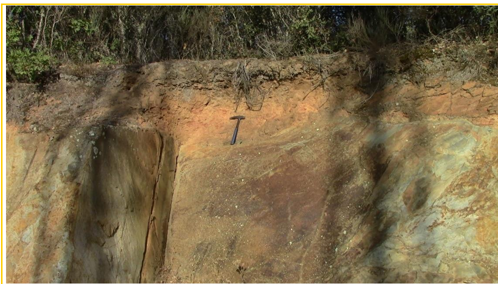
Imagen 32. Detalle de un afloramiento rocoso superficial, talud de la carretera a la galería margen izquierdo, con su perfil de alteración poco desarrollado.
