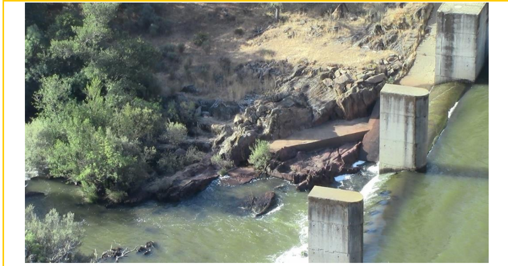
Imagen 26. Afloramiento rocoso, roca Tipo II, en el emplazamiento de la Casa de Máquinas.
