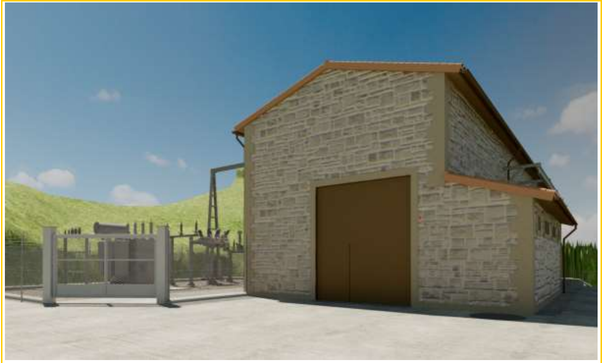
Imagen 20. Central de Irueña. Entrada a central y a subestación.
