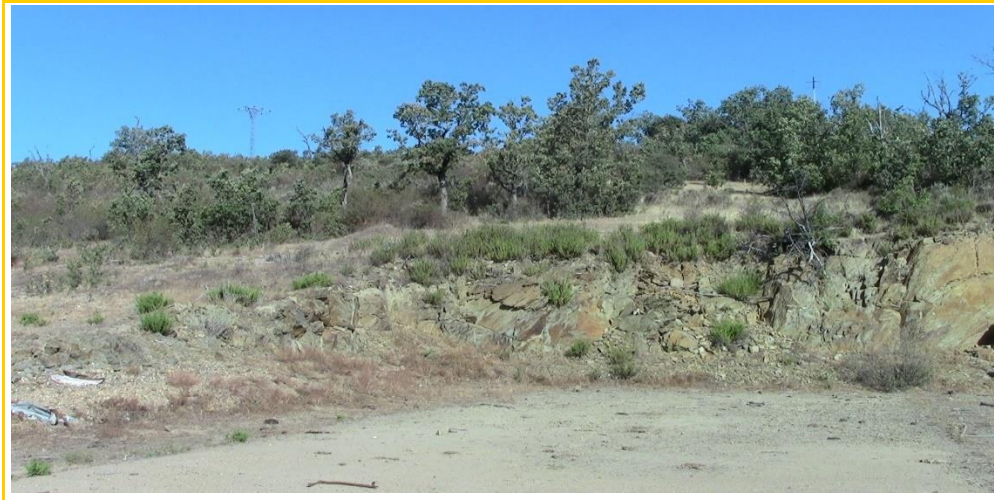
Imagen 39. Perfil de alteración de la roca en la torre nº 10, al fondo torres de la línea existente.
