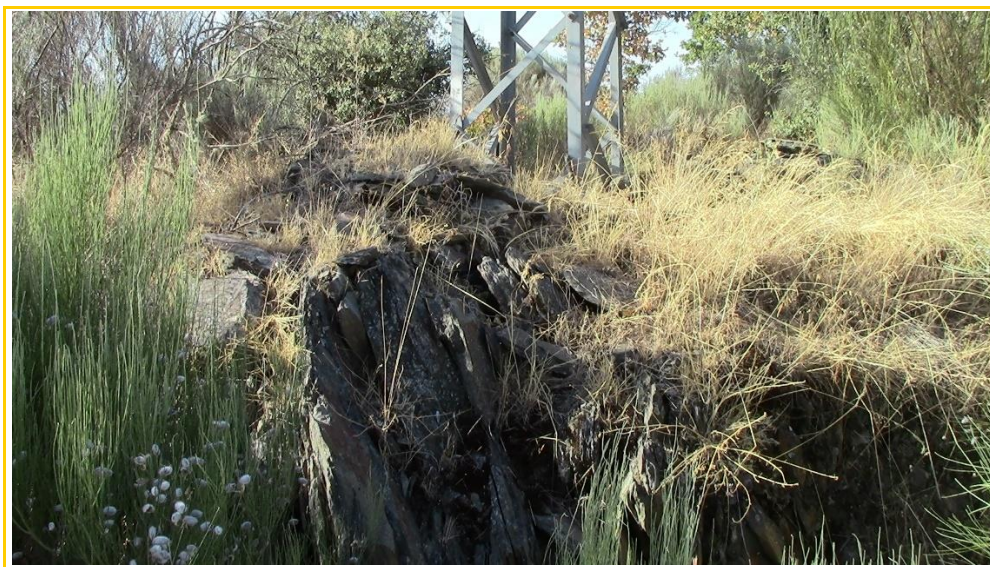
Imagen 36. Cimentación de la torre de la línea existente a la altura de la torre nº 7.
