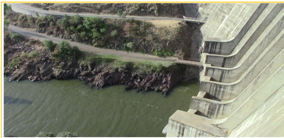
Imagen 16. Detalle del tramo inicial del trazado de la Tubería Forzada, sobre roca de Tipo II en una serie monoclinical invertida, buzamiento a la izquierda y techo a la derecha.
