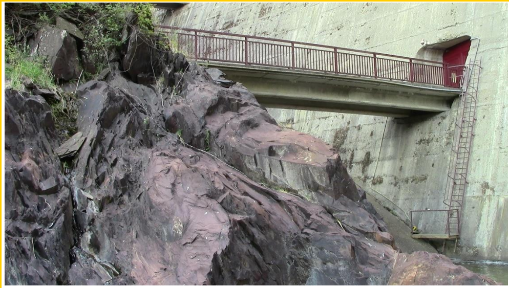
Imagen 17. Aspecto de la roca, en el tramo inicial de la Tubería, lavada por el desagüe de fondo. Tipo II de aspecto masivo al tratarse de un nivel desorganizado-replegado ( slump ).
