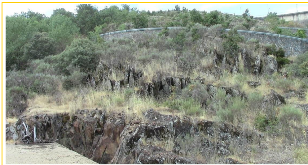
Imagen 22. Tramo final del trazado de la Tubería Forzada con afloramientos rocosos a modo de crestas y agujas fruto de la erosión diferencial superficial.
