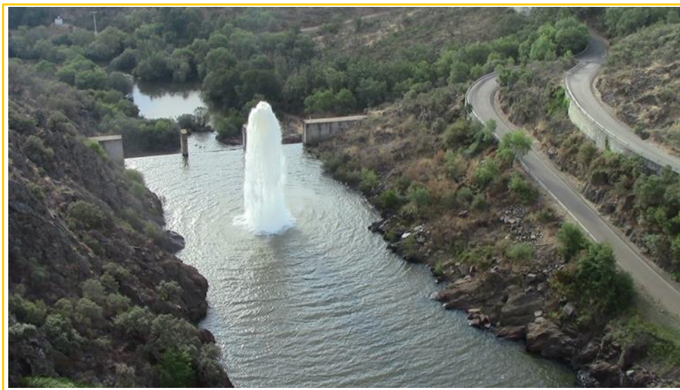
Imagen 11. Carreteras de acceso a las diferentes galerías y cuenco de amortiguación. Margen derecha con afloramientos rocosos continuos en el trazado de la Tubería Forzada y, al fondo, donde se emplazará la Casa de Máquinas.
